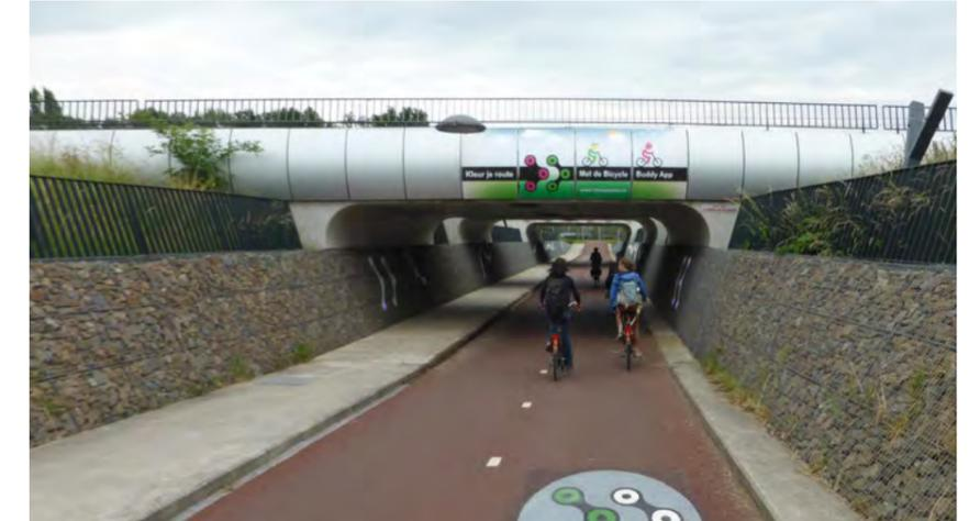
Rijnwaalpad - Schnellradweg mit Unterführungen in den Niederlanden zwischen Arnhem und Nijmegen mit abgeschrägten Seitenwänden
