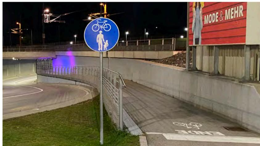
Abgestzter Geh- und Radweg mit bewegungssensitiver und bunter Beleuchtung bei einer Bahnunterführung in Wolfsberg, Kärnten
