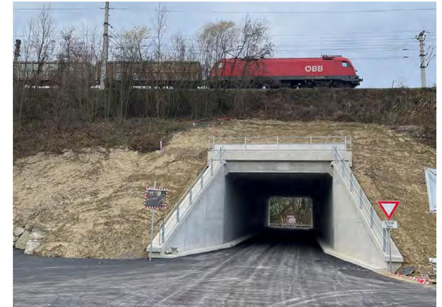
Vorgefertigter Tunnelvortrieb unter ÖBB-Gleisen hindurch.
