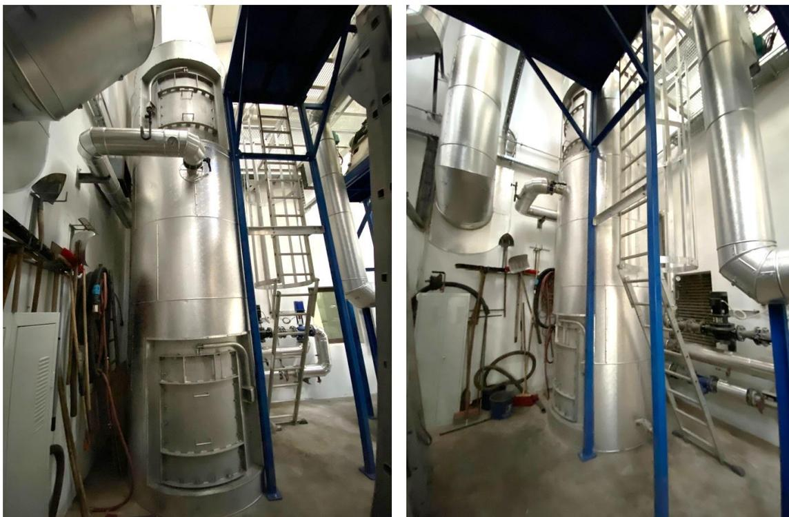
Abbildung 2 und 3: Rauchgas-Wärmerückgewinnung © Josef Riebenbauer
