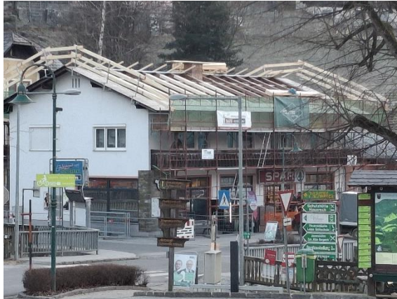
Abbildung 2 und 3: Statische Ertüchtigungen am Dachstuhl, beidseitige Sparrenverstärkung © Gemeinde St. Kathrein am Hauenstein
