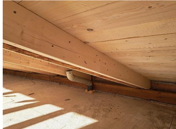
Abbildung 2 und 3: Statische Ertüchtigungen am Dachstuhl, beidseitige Sparrenverstärkung © Gemeinde St. Kathrein am Hauenstein
