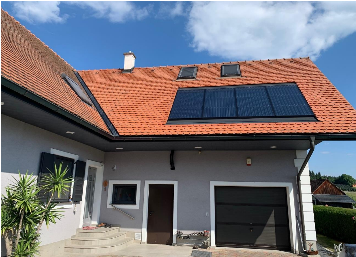
Abbildung 1: Einfamilienhaus mit thermischer Solaranlage in Bad Schwanberg © Andreas Totz
