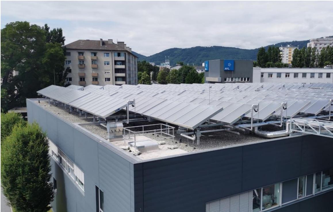
Abbildung 1: Solarthermische Anlage am Dach eines Bürogebäudes der AVL © SOLID Solar Energy Systems GmbH
