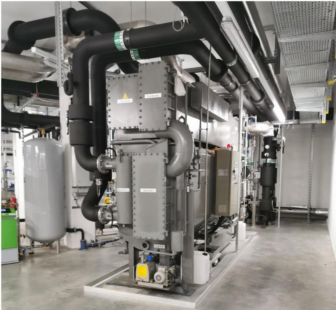
Abbildung 2: Absorptionskältemaschine im Anlieferungszustand (vor Montage der Wärmeisolierung) © SOLID Solar Energy Systems GmbH
