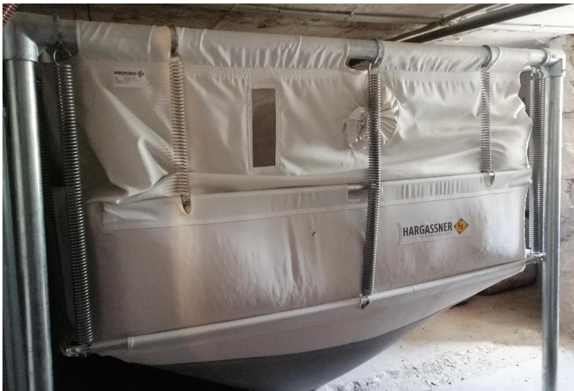
Abbildung 4: Pellet-Sack-Silo 4,4-6,0t © Diözese Graz-Seckau - Katholische Kirche Steiermark
