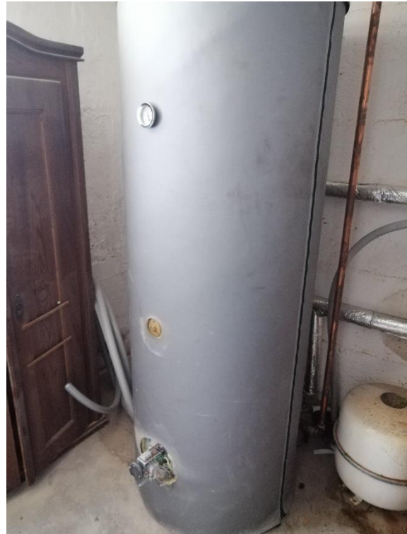
Abbildung 3: Pufferspeicher © Diözese Graz-Seckau - Katholische Kirche Steiermark
