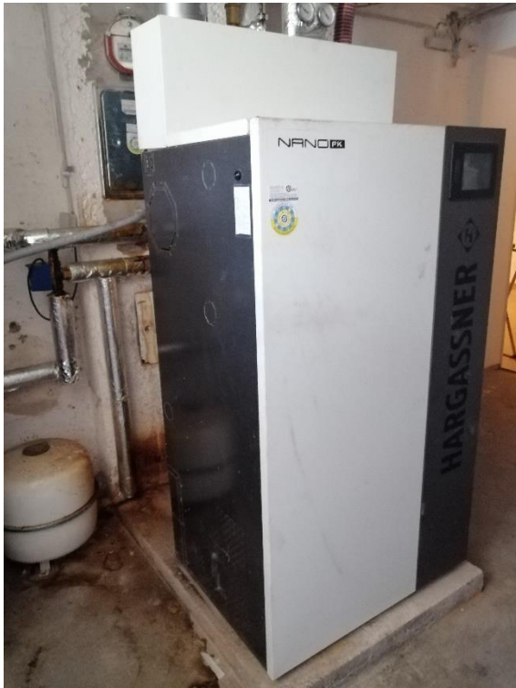
Abbildung 2: Pelletskessel © Diözese Graz-Seckau - Katholische Kirche Steiermark
