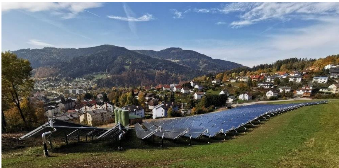
Abbildung 2: Thermische Großsolaranlage inklusive Pufferspeicher © SOLID Solar Energy Systems GmbH
