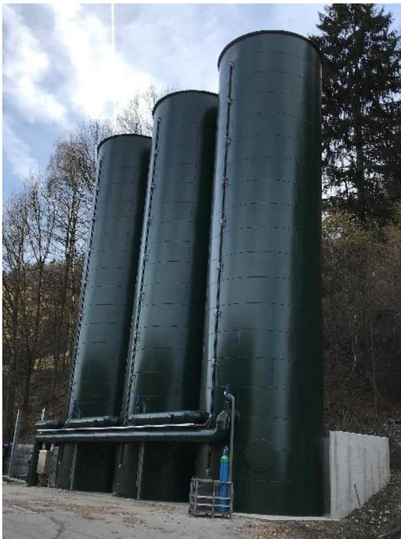
Abbildung 3: Pufferspeicher © TB Riebenbauer
